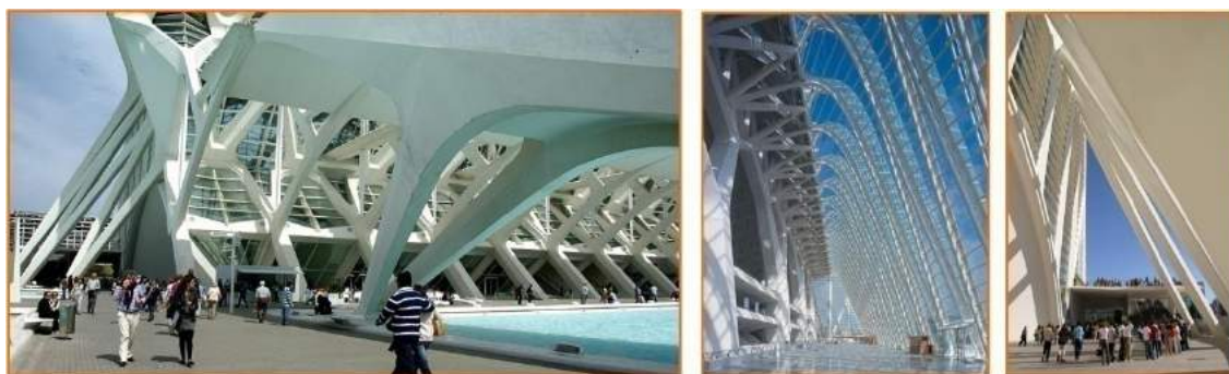
Pavimento Térreo: Vista externa de um acesso (à esq.), Vista interna (centro) e Vista de outro acesso (à dir) Fonte: http://www.cac.es/prensa/galeria/museo/
