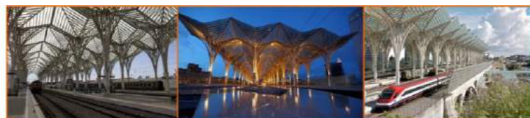
Figura 16: Imagens do Sexto pavimento da Estação do Oriente - Lisboa.
