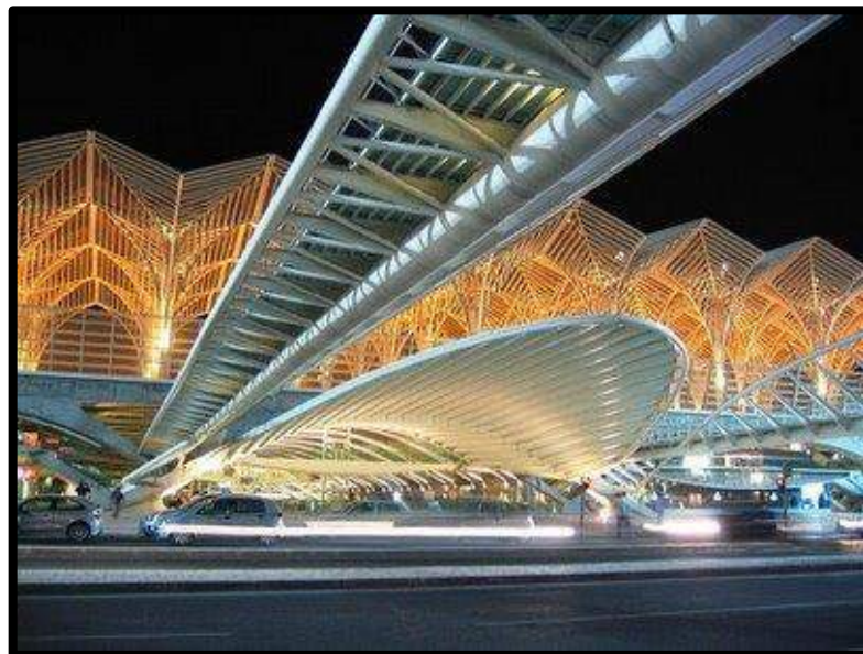
Figura 12: Marquise em aço coberta de vidro da Estação do Oriente.
